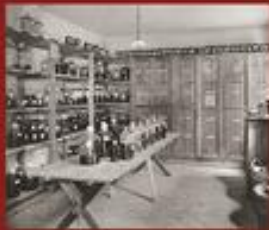
Im Inneren der Behringwerke
